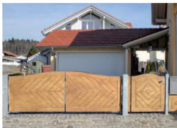
Hof-Drehtor mit individueller Motivfräsung in einer Okoume Bootsbauplatte
