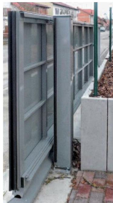
Torantrieb und Steuerung sind in der Aluminiumsäule untergebracht
